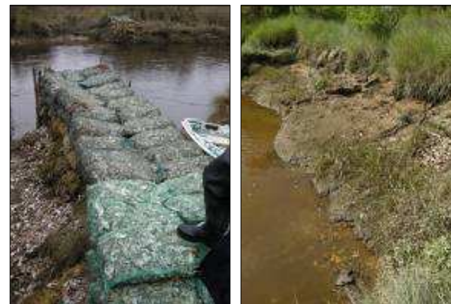
Figure 12- Berge restaurée après enlèvement d'un pitt.
