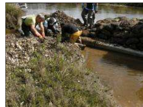
Figure 13 - Chantiers d'enlèvements de puits. J.ALLOU
