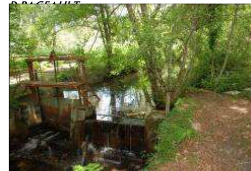
Figure 14 - Photos écluse de la Machinotte.
