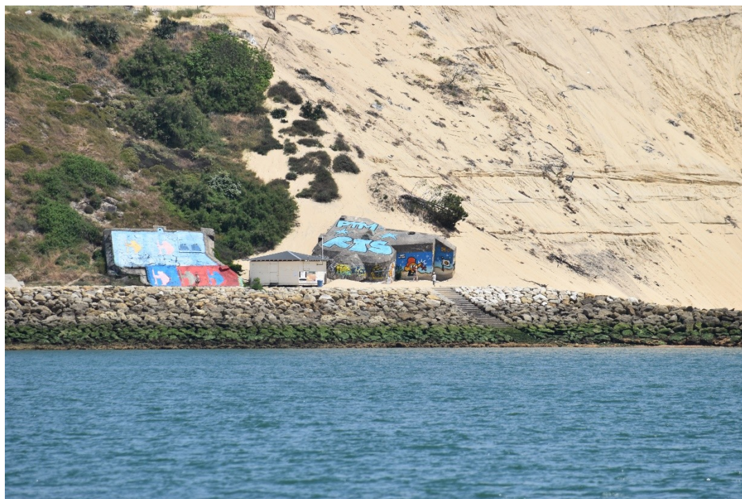
Amer cité à l'article 1 - limite nord Blockhaus au pied du lieu-dit « La Corniche »
