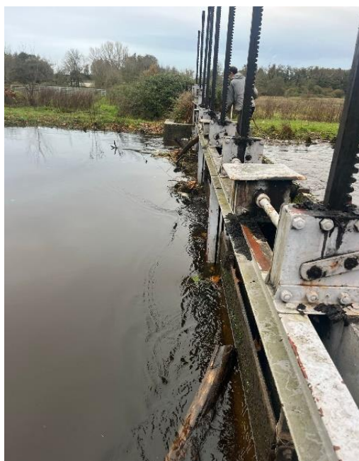
Nettoyage des embâcles pris dans les pelles du Baron
