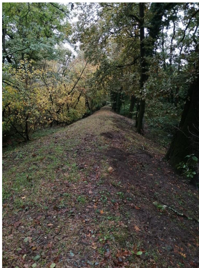
Digue du sable lors de la prospection de son intégrité structurelle
