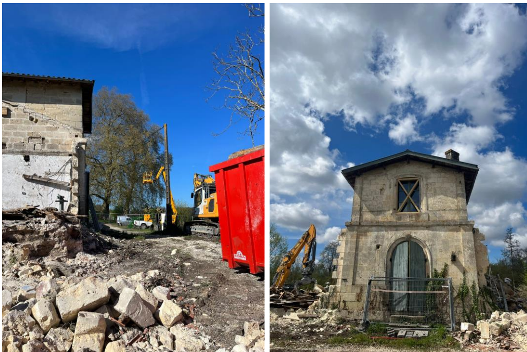
Travaux de démolition de la maison de la Réserve
