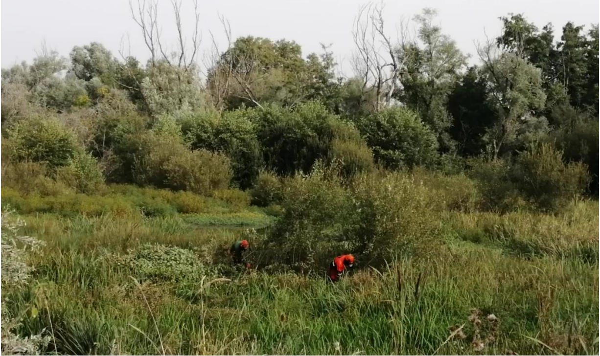
Chantier RTE sous ligne électrique
