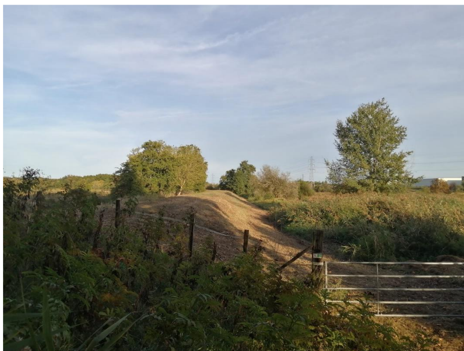
Digue du sable post-épareuse
