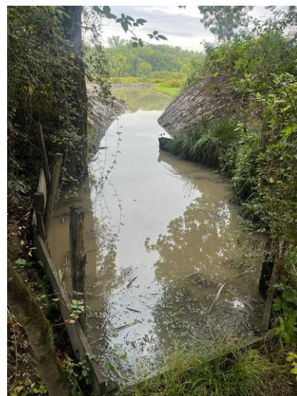
Ouvrage supprimé à l'exutoire du lac de GVN
