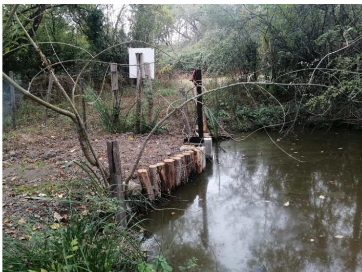
Pelle réparée à l'exutoire sur la Jallère
