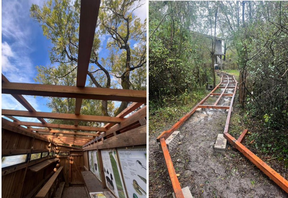
Travaux en cours sur les observatoires à l'automne 2023
