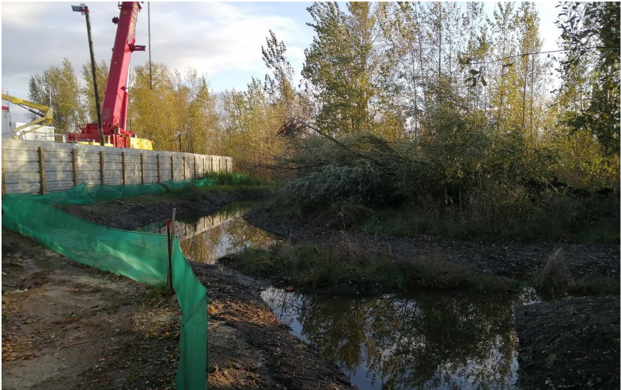
Site Equinix – crédit photo : SEPANSO
