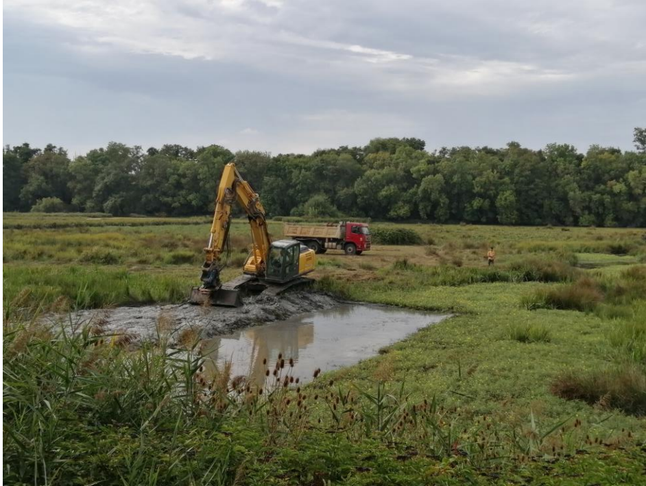
Travaux hydrauliques sur GVN – entreprise SUREAU
