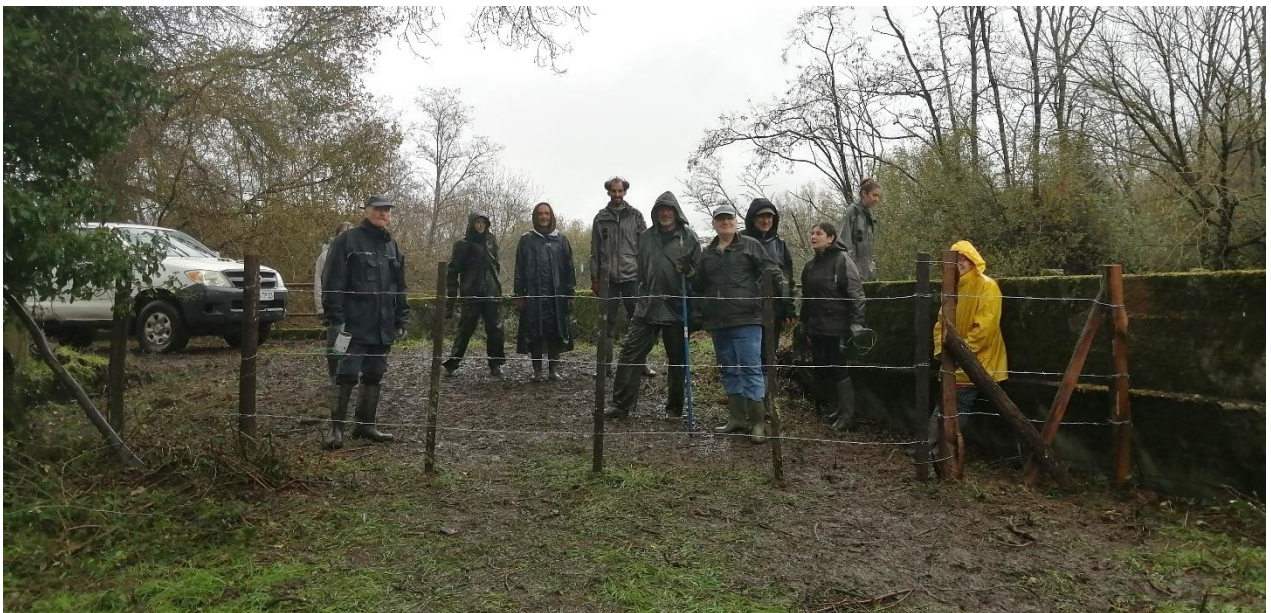
Chantier bénévole de réfection de clôtures
