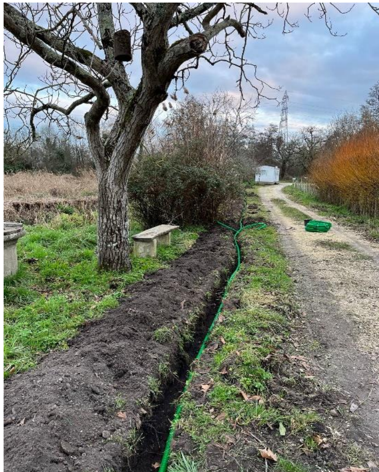
Travaux en cours au Baron
